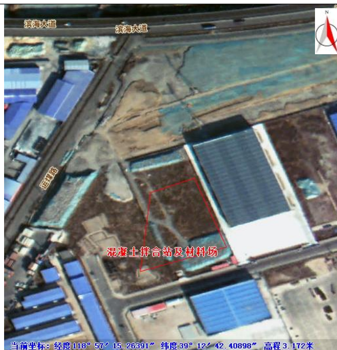
混凝土拌合站及材料场
