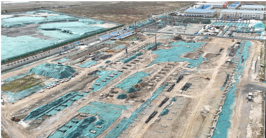
图 1-5 施工场地现状照片（拍摄时间 2023 年 12 月）
