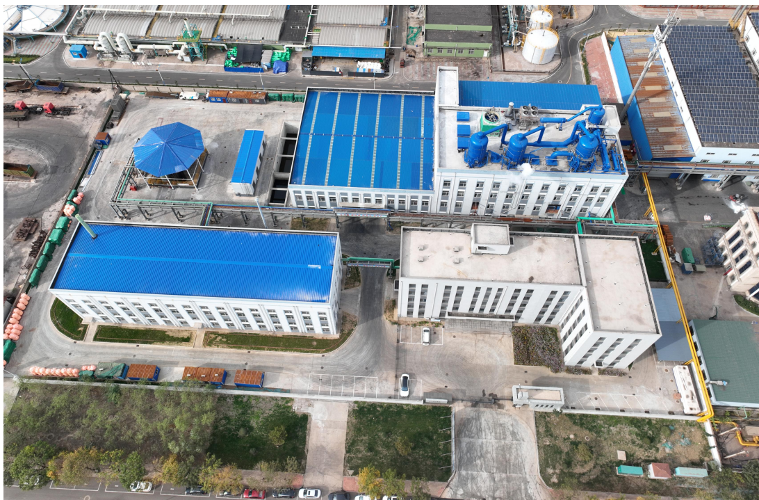
图 1-6 工程区现状地貌图（拍摄于 2023 年 10 月 19 日）
